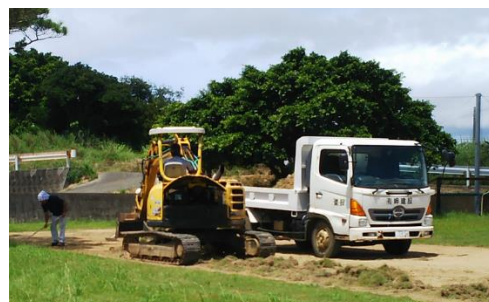
整備当日の作業の様子
